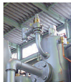
SD120のボイラー設置状況
